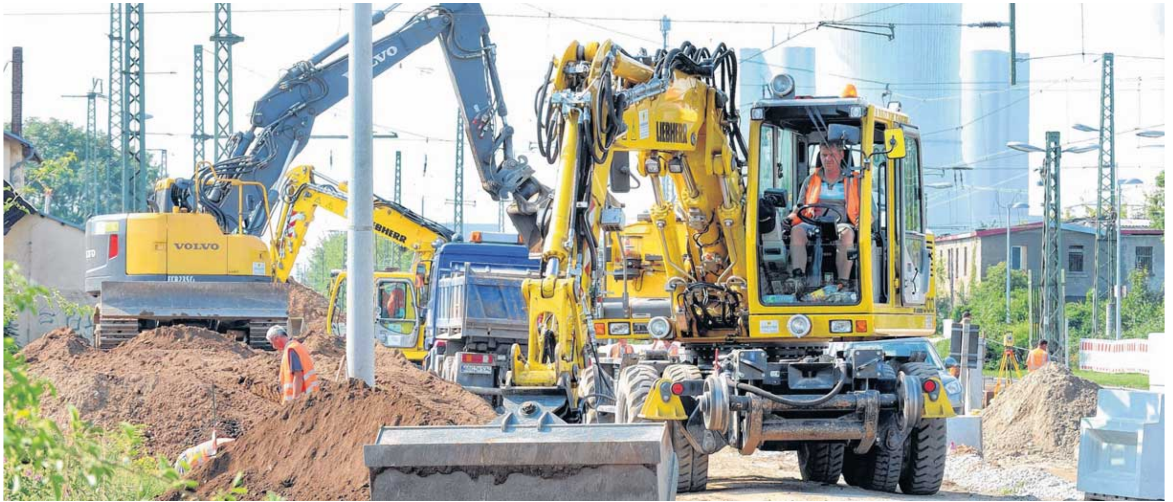
Die Bauarbeiten für das neue Gleisbett im Böhlener Bahnhof laufen auf Hochtouren. Zukünftig sollen dort ICE-Züge mit höherer Geschwindigkeit den Bereich befahren können.
